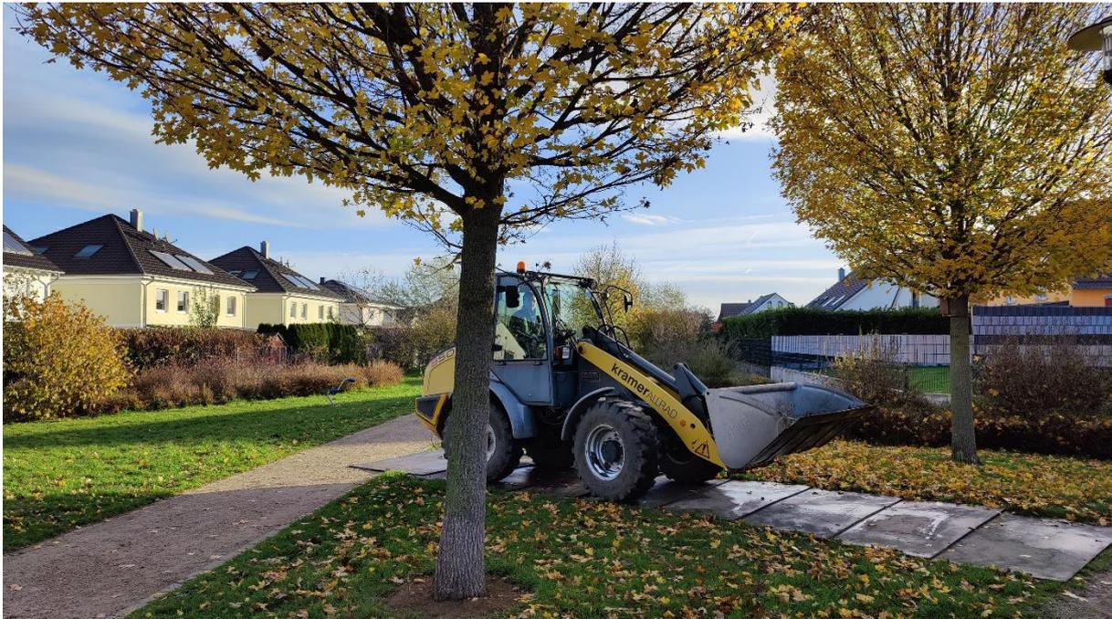
***Hier in Weilerswist Süd hat der Bauunternehmer alles richtiggemacht: Durch das Verlegen der befahrbaren Platten werden die druckempfindlichen Baumwurzeln geschont.***
